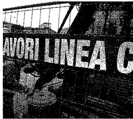
Scavi Uno dei cantieri della Metro C
