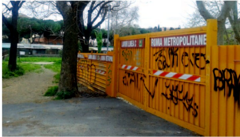
Il cantiere già allestito all'interno dei giardini di via Sannio.
